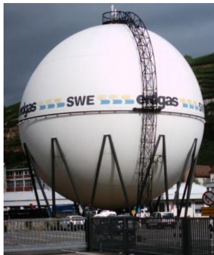
Рис. 3.19. Резонансний метод ультразвукового контролю для контролю газгольдерів (стаціонарне газосховище — металічний резервуар для накопичення і зберігання газу)
