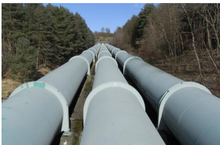
Рис. 3.18. Резонансний метод ультразвукового контролю можна застосовувати для контролю трубопроводу
